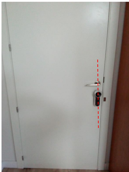
Figura 12 Montaje sobremesa con orientación incorrecta.
