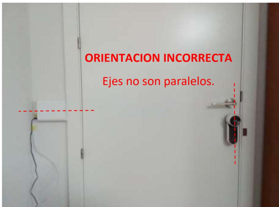
*Figura 10 Montaje en pared con orientación incorrecta.*
